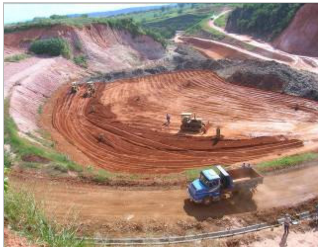
Figura 37 - Vista da base do futuro aterro sanitário de Araxá, já contendo algum volume de “lixo velho” aterrado, advindo da área contígua, onde é operado o lixão/aterro controlado. Ao fundo observa-se o sistema de tratamento de chorume.
